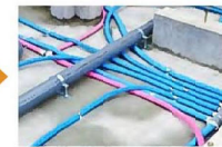
耐久性の優れた樹脂管に交換。
